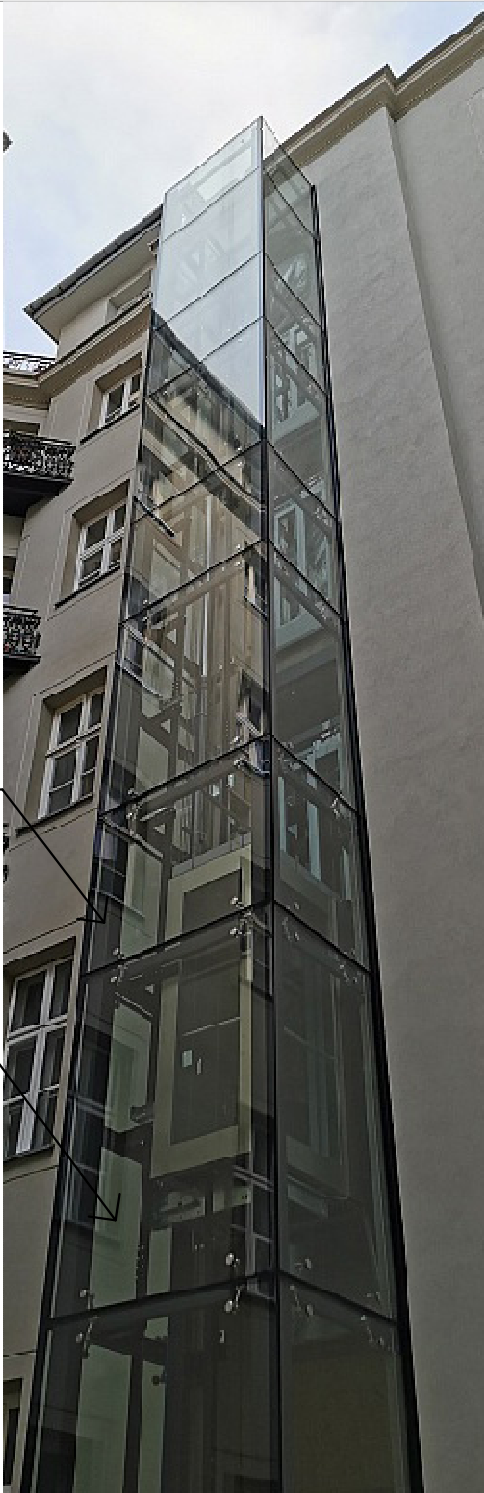
stalowa konstrukcja szybu "ukryta" za bezszprosowym szkleniem
