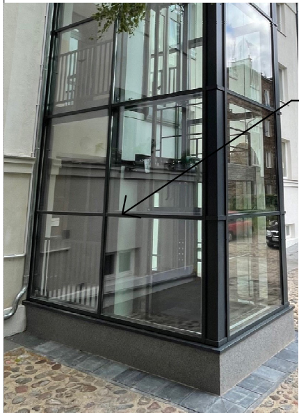
w przyziemiu: ślusarka aluminiowa- szklenie ramowe
